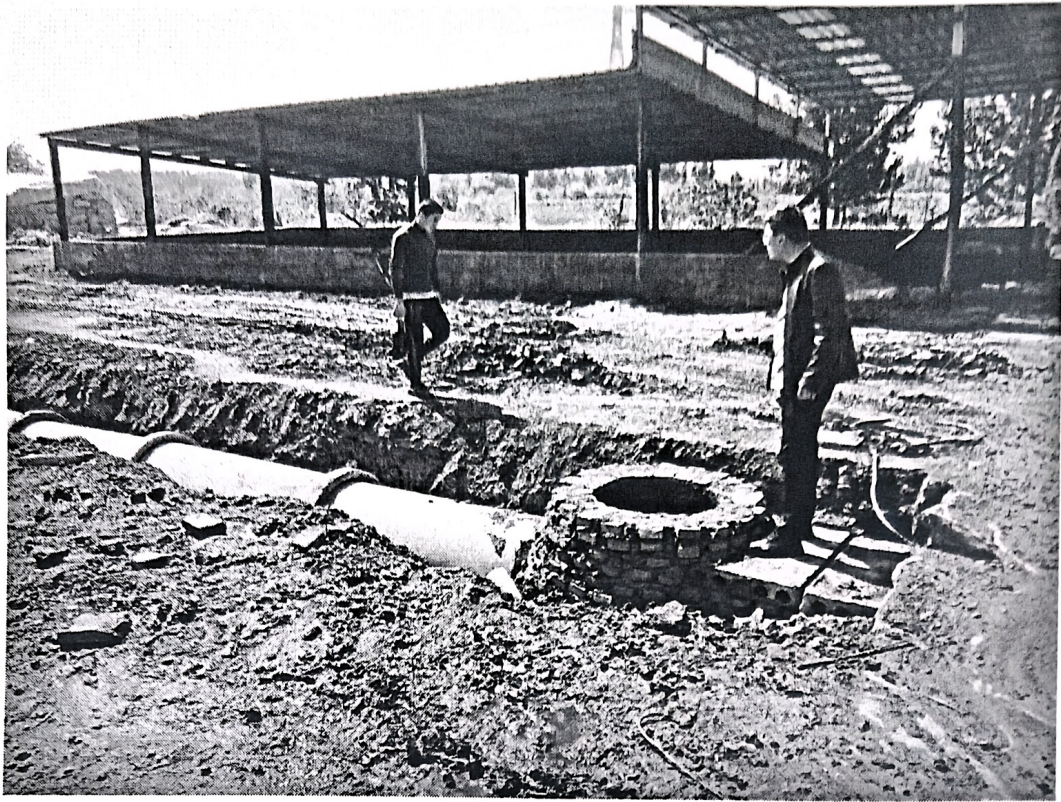
润广改造雨水管网
