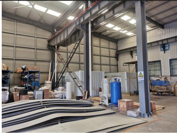
探伤工作场所拟建区域南侧-下料车间
