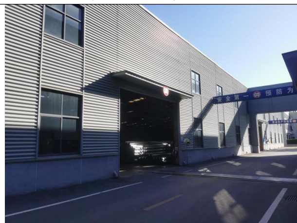
探伤工作场所拟建区域东侧-东车间
