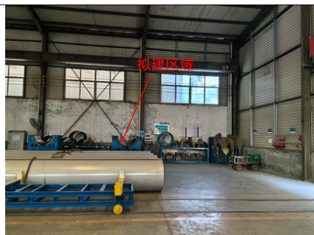
探伤工作场所拟建区域
