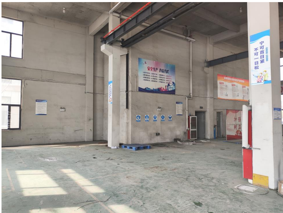
图 2-4 租赁车间内部现状图
