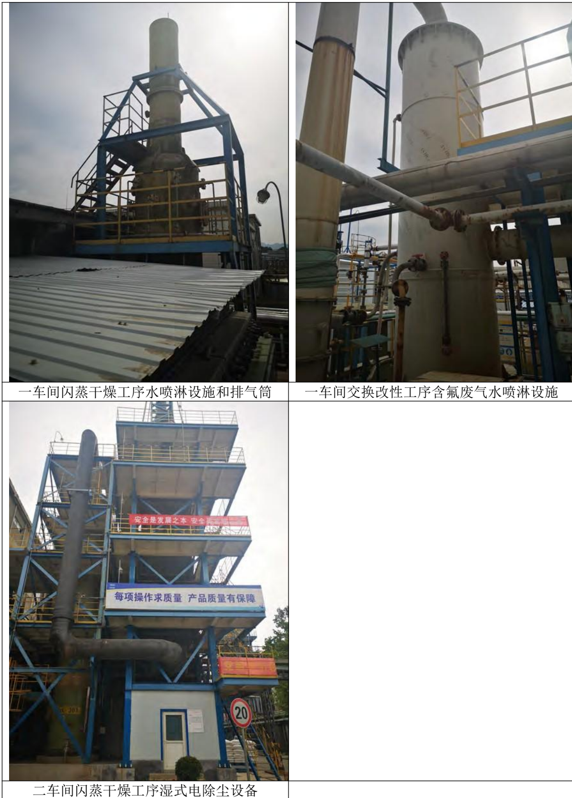
图3-13 分子筛项目废气处理设施图
