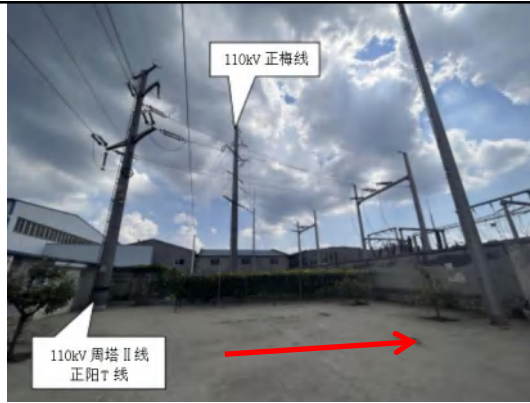
图 2-2 电缆线路路径现场照片
