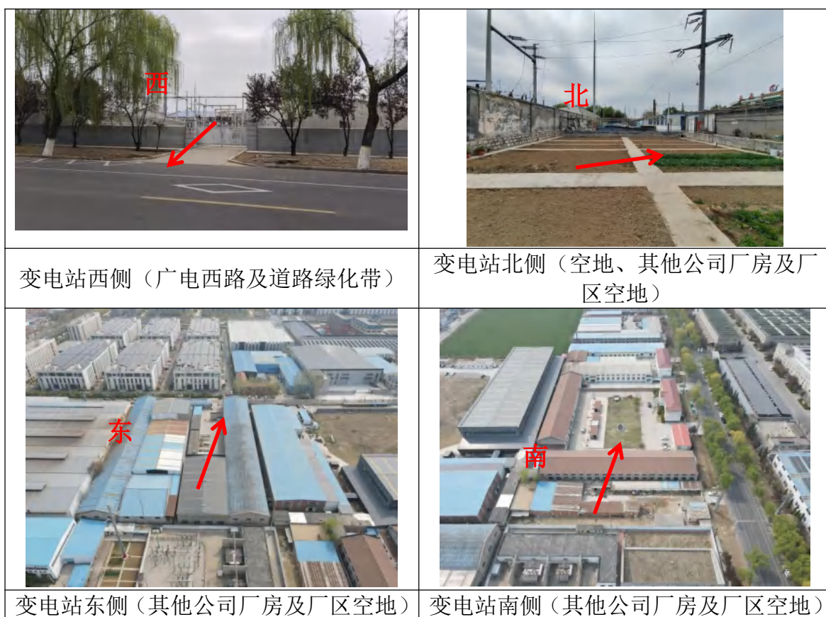
图 2-1 变电站四周环境现场照片
